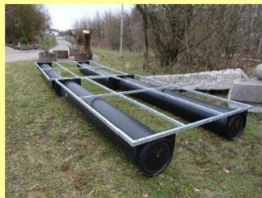
Bauanleitung Brutfloß für Flusseeschwalben (4 x 3 m)
