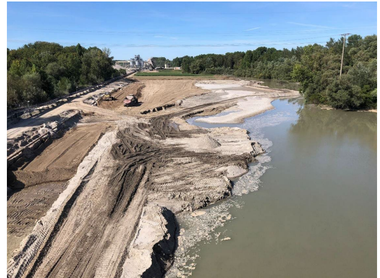
Große Spülsandfläche und Einbau Bodenabtrag von Erweiterungsfläche mit natürlicher Waldsukzession und Aufforstung - Beispiel Kiesgrube Kern – Iffezheim bei der Staustufe
